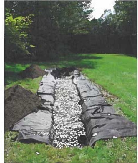
Figure 1 : Exemple de tranchée d'infiltration
